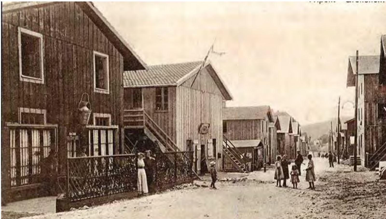
Barackensiedlung «Tripoli» – Bau Grenchenbergtunnel, Grenchen
