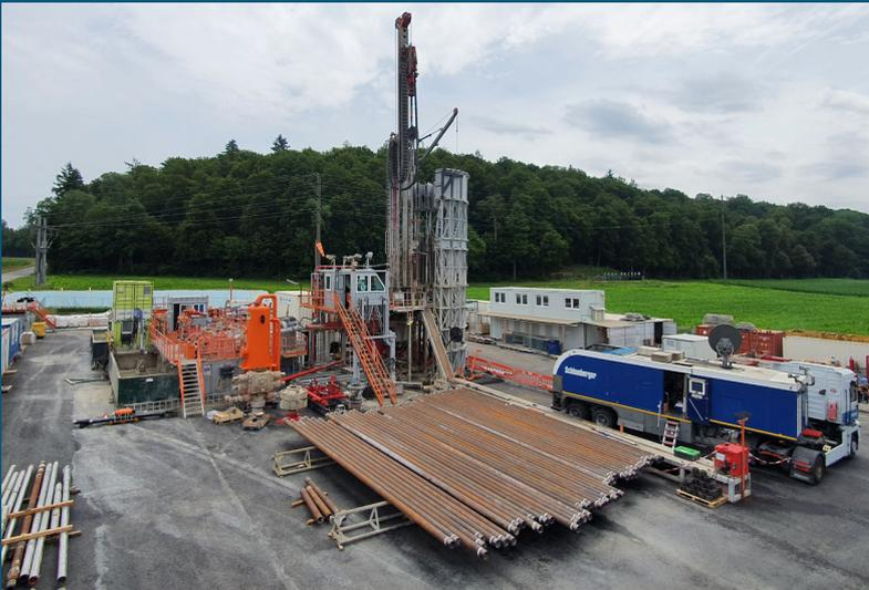
Bohrplatz vor Einbau der Verrohrung (Stahlrohre)
